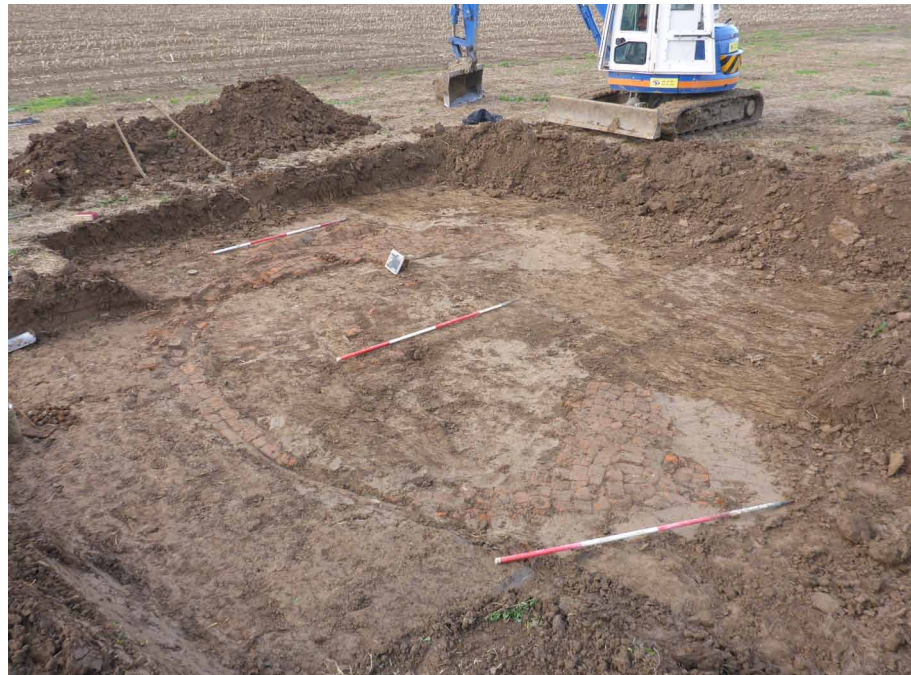
Afb. 4.7 – Vlakfoto van locatie 7 genomen vanuit het zuid-oosten.
